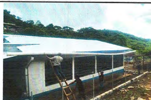
Foto 6: Colocacion de canal.
