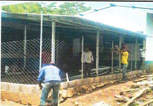
Foto 5: Colocacion de malla en el corredor del establecimiento.
