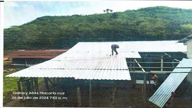
Foto1: Avance del entechado del establecimiento
