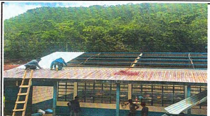
Foto 2: colocacion de lamina del modulo uno.
