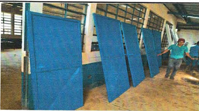
Foto 3: Sustitucion de puertas.
